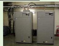
陸上通信施設の整備
