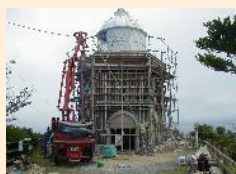
航路標識の改修工事
