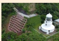
法面保護工事
