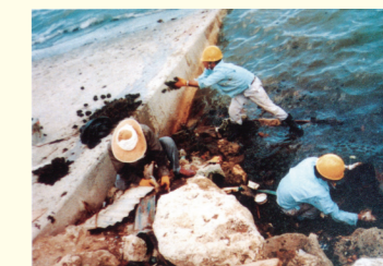
廃油ボールの除去作業
