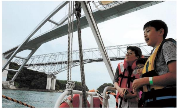
宇城市三角町と上天草市大矢野町を結ぶ新天草1号橋「天城橋」(手前) と1号橋「天門橋」をくぐり抜けました
