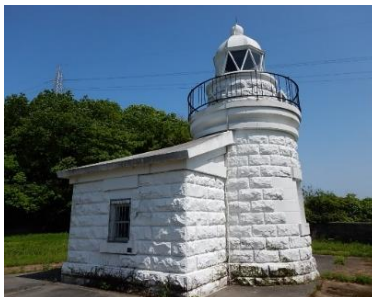
戸馳島灯台(石造) 明治31年建設 戸馳島(宇城市)の南側に設置しており、蔵々ノ瀬戸を航行する船舶の指標となっています
