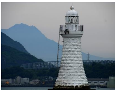
寺島灯台(石造) 明治31年建設 寺島(宇城市)の東側に設置しており、三角港を航行する船舶の指標となっています
