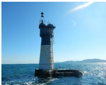
五通礁灯標(コンクリート) 明治37年建設 早崎瀬戸(五和町鬼池沖)の岩礁上に設置しており、標識の北側が安全であることを示しています
