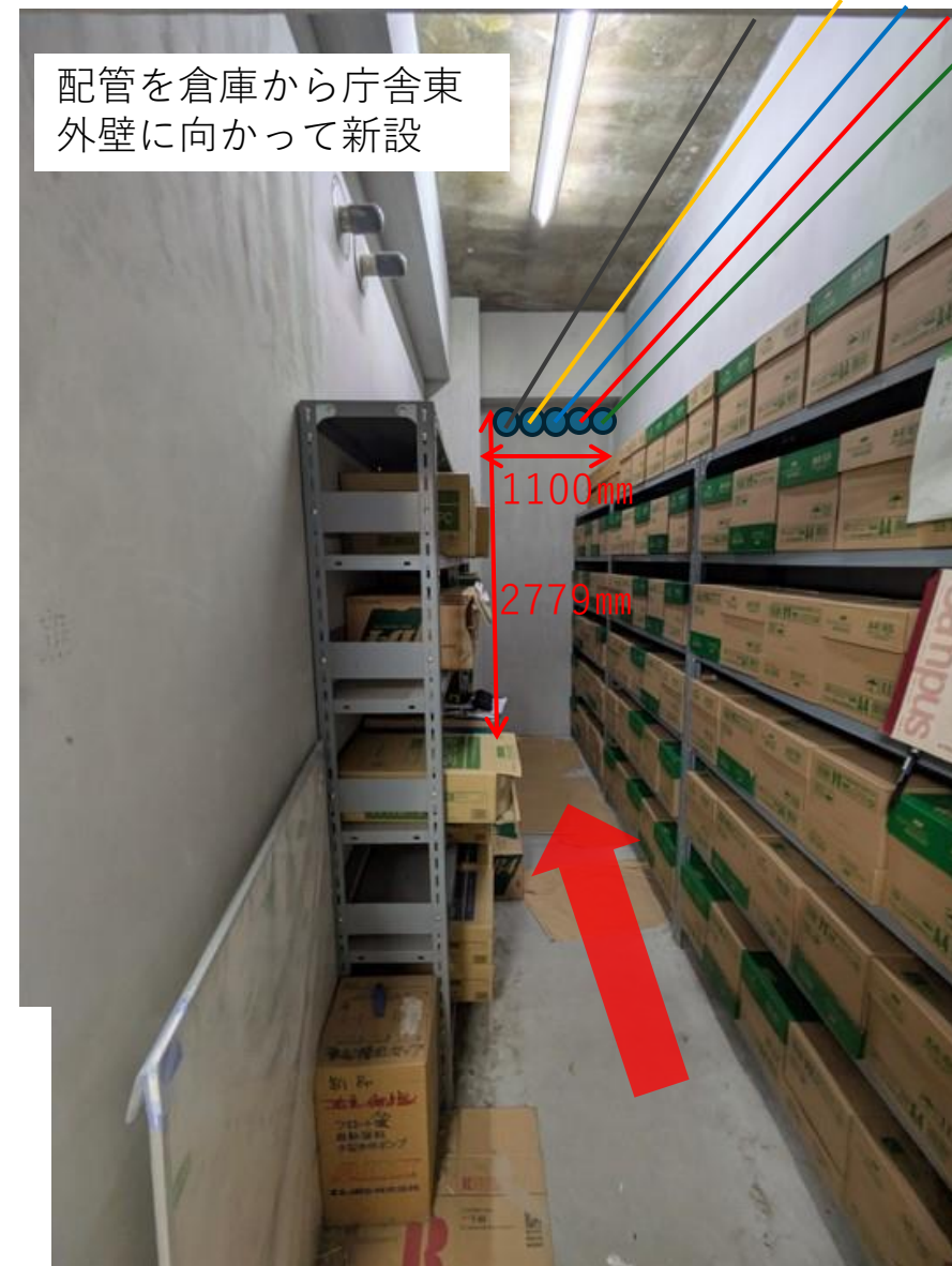
倉庫内 (庁舎東面外壁側) 写真⑤
