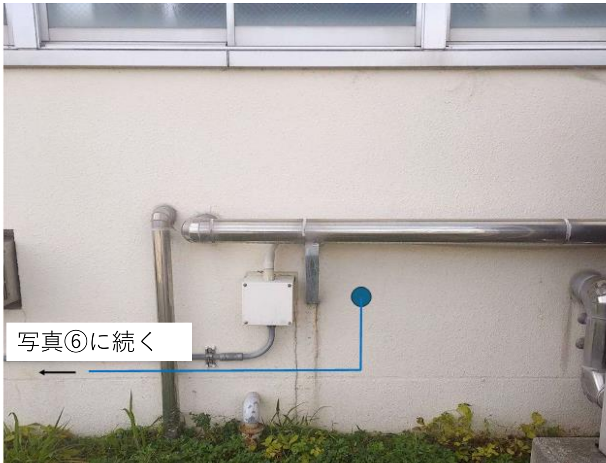
写真⑦既設水道管拡大図
