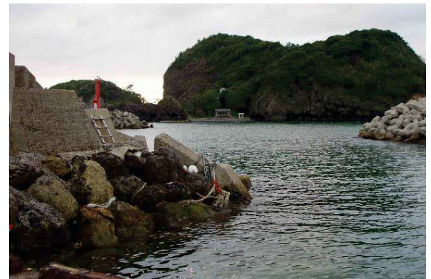
事故が発生した防波堤
