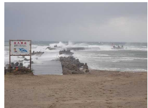
事故が発生した防波堤
