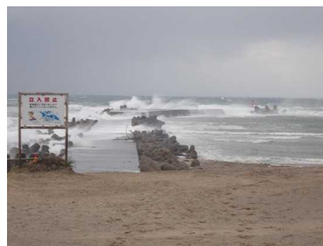
事故が発生した防波堤
