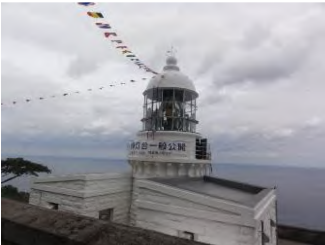
灯台内部の見学（経ヶ岬灯台）
