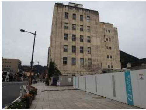
関門海峡らいぶ館 建物 (JR門司港駅前)
