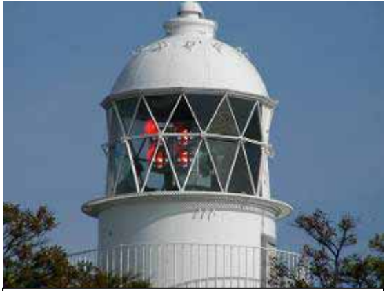
灯籠内で光るLU-M型灯器 (10秒周期で1回転します。) 平成14年9月15日に新替しました。
