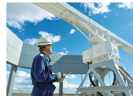
レーダー装置点検中の技術官
