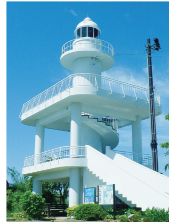
雑賀崎灯台 (和歌山県和歌山市雑賀崎)
