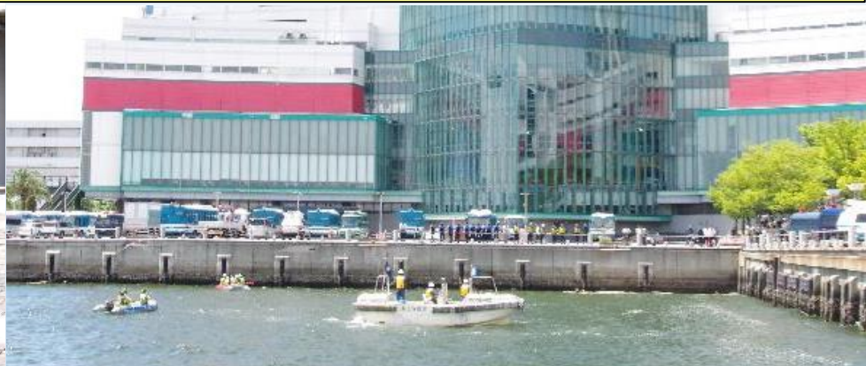
阪神港大阪区オズ岸壁
