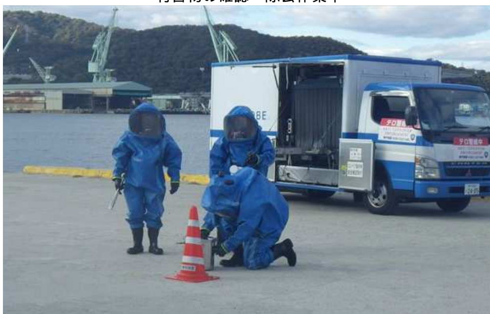
有害物の確認・除去作業中
