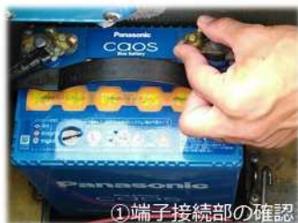
①端子接続部の確認
