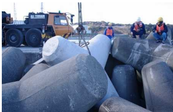
消波ブロックの据付作業（私は、怖くて歩けません。）
