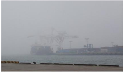
八戸港内の濃霧の状況
