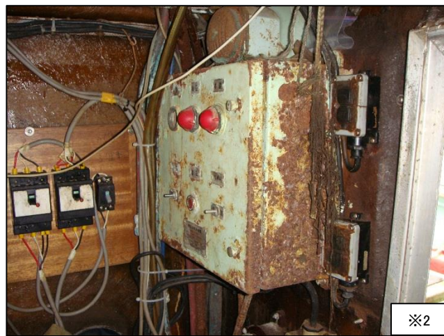
電装機器の腐食 ※2
