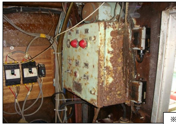
電装機器の腐食
