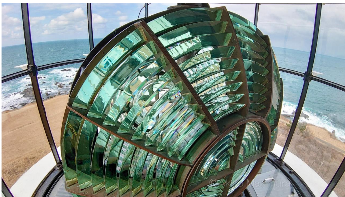
鮎ヶ埼灯台と同型レンズ(3等大型フレネルレンズ、直径約1.7m、重量約800kg)
