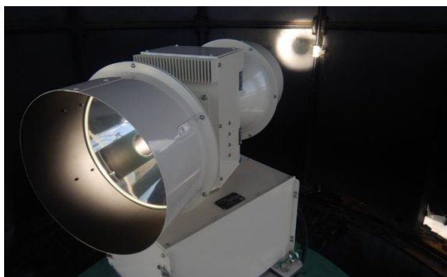
LED光源を使用したLED回転型灯器に変更
