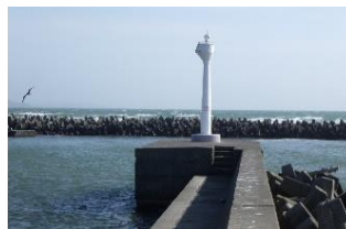
西稚内港北防波堤灯台
