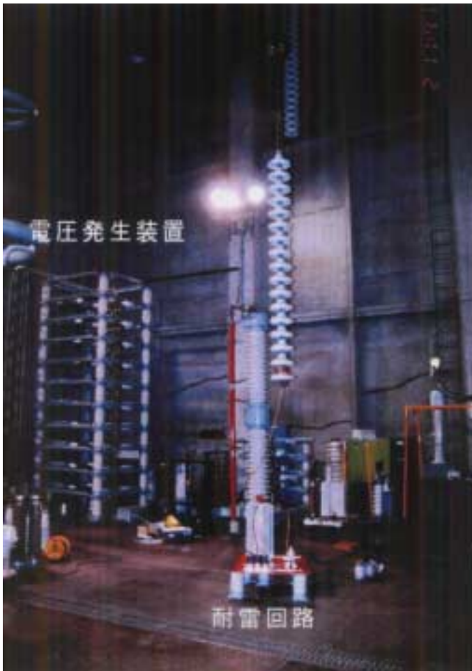
耐電圧状況写真
