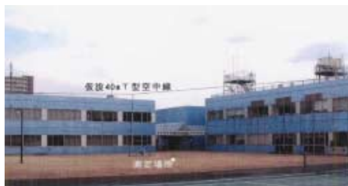
測定状況写真
