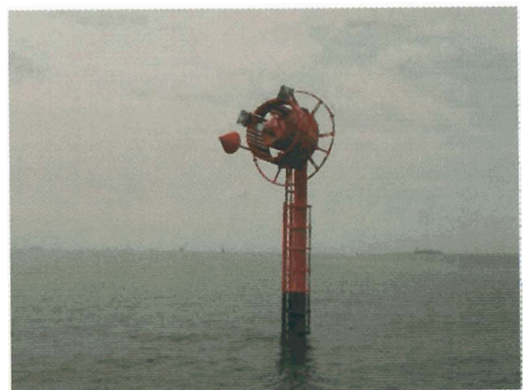
浮体式灯標の船舶接触事故事例 「名古屋港東航路第六号灯標（名古屋）」
