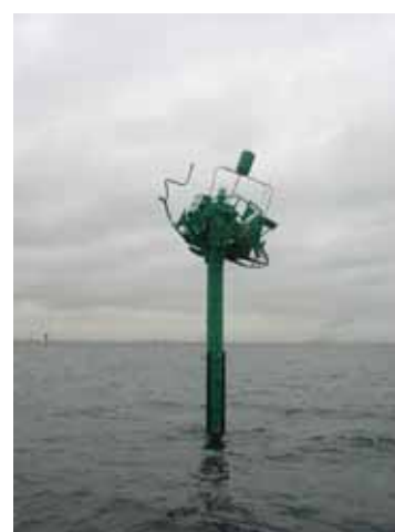
浮体式灯標の破損事故事例 千葉港口第七号灯浮標(千葉)
