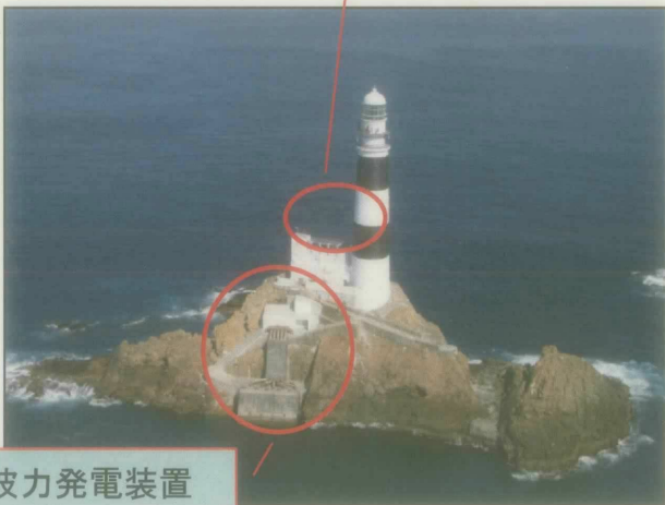
波力発電と太陽光発電(複合電源) 「水ノ子島灯台」 (大分県)
