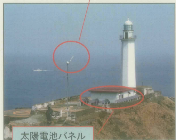
風力発電と太陽光発電(複合電源) 「松前小島灯台」 (北海道)
