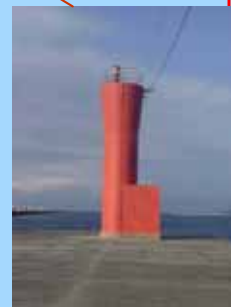
西之表港南防波堤灯台 (風向・風速)
