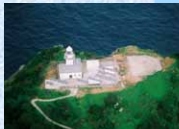
草垣島灯台 (風向・風速・気圧)
