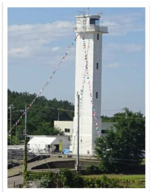
晴れた日に撮影した大野灯台
