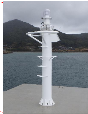
新設された簡易標識
