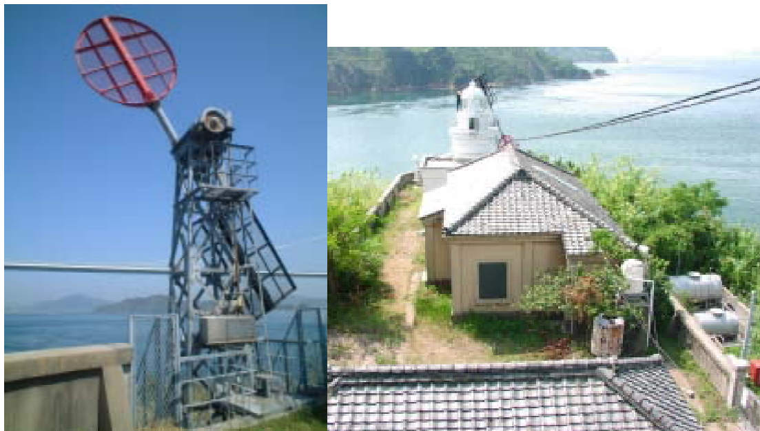
腕木式形象物：(丸い)赤が上にあがると潮流は北流であることを、(四角の)黒が上がると南流であることを示します。(夜間は白い灯塔から発せられる赤色の灯光で北流であることを、緑色の灯光で南流であることを示します。)
