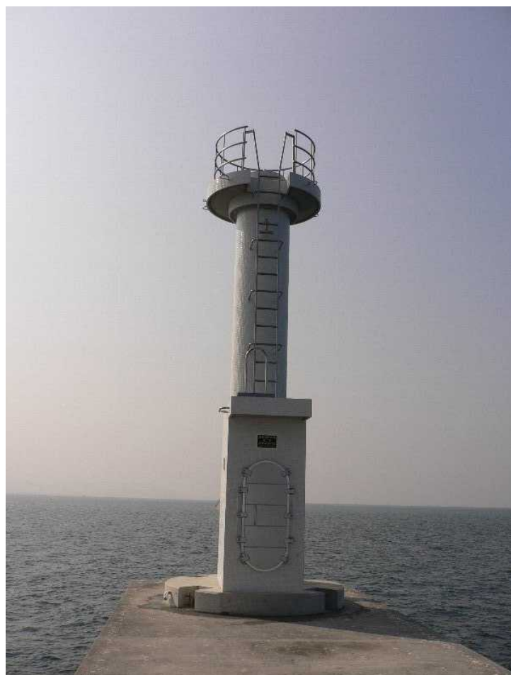
灯塔据付は無事完了しました。 この灯台の点灯は、11月13日の予定です。
