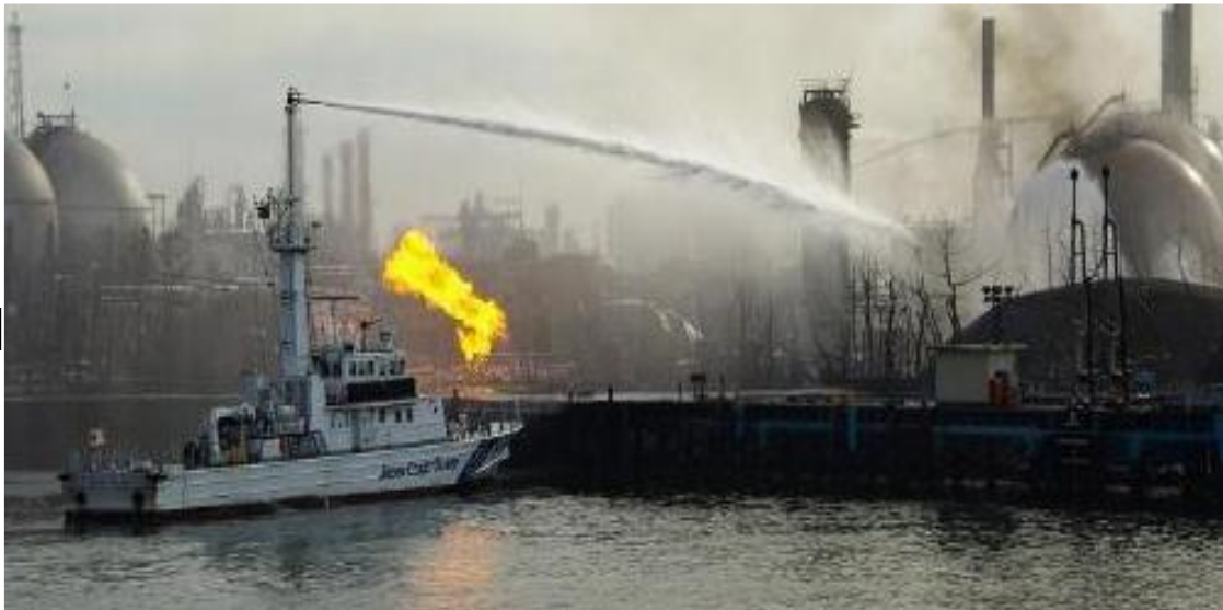
(東日本大震災における臨海部施設の消火活動)
