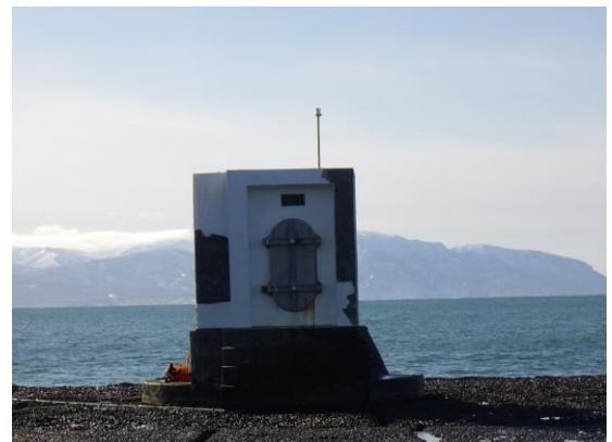
（仮灯設置状況）
