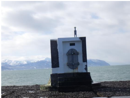
再設置した仮灯
